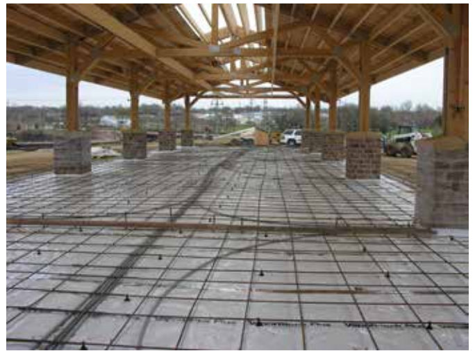
Under-Slab Vapor/Gas Retarder
